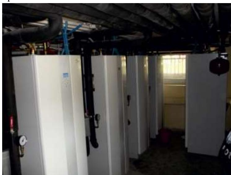
Встановлення автономного джерела теплової енергії в вигляді комплексу теплових насосів «грунт-вода» потужністю 80 кВт з частковим переобладнанням індивідуального теплового пункту, приведе до зменшення споживання теплової енергії від постачальної організації, на величину потужності вироблену тепловими насосами, також до зменшення витрат на опалення.
